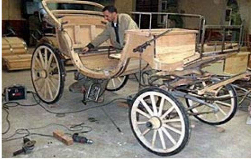
Fotoğraf: 96 Faytonun ana gövdesine, oturma yerlerinin eklenmesi. (Sanal, 2011)
